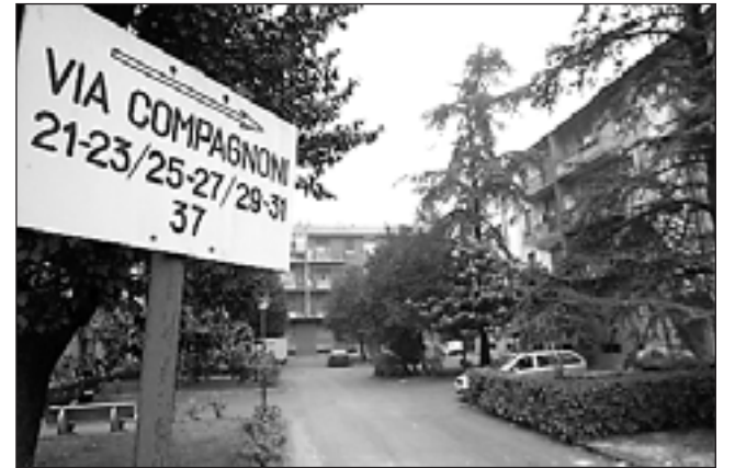
Case popolari in demolizione in via Compagnoni
