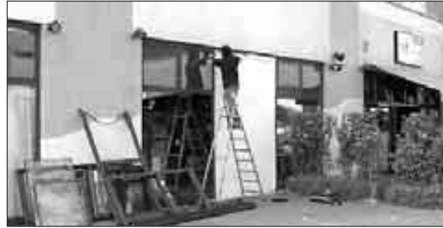
I lavori di riparazione della vetrata del locale di via Tintoretto
